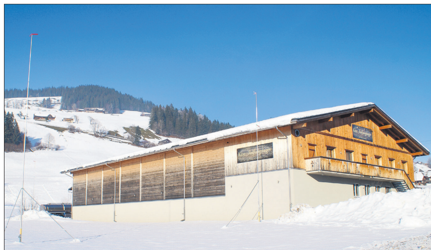
Neben das bestehende Käse-Reifungslager will die Genossenschaft Hohgant-Käserei Schangnau einen Neubau aufstellen.
